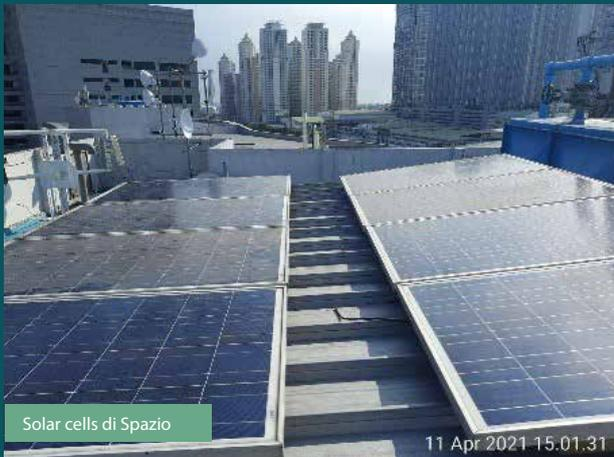
Dengan memanfaatkan sel surya dan baterai bekas, Spazio, gedung perkantoran kami di Surabaya, berhasil memanfaatkannya kembali untuk penerangan di *basement* dan tangga daruratnya. Masing-masing dari delapan unit sel surya yang digunakan dapat memberikan tegangan 19V DC dengan 6A. Dengan inisiatif ini, Spazio dapat mengurangi pemborosan dan menghemat biaya hingga Rp 8,8 juta/tahun.
